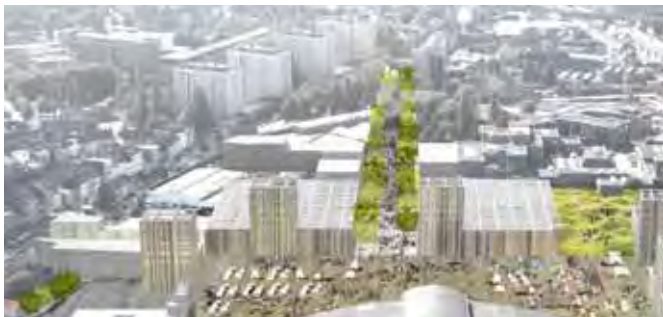
Vue de la nouvelle percée donnant sur la Chaussée de Mons, traversant les parcelles Renault
