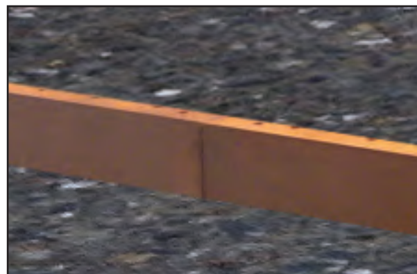
overgang tussen niveau's: stalen opkanten
